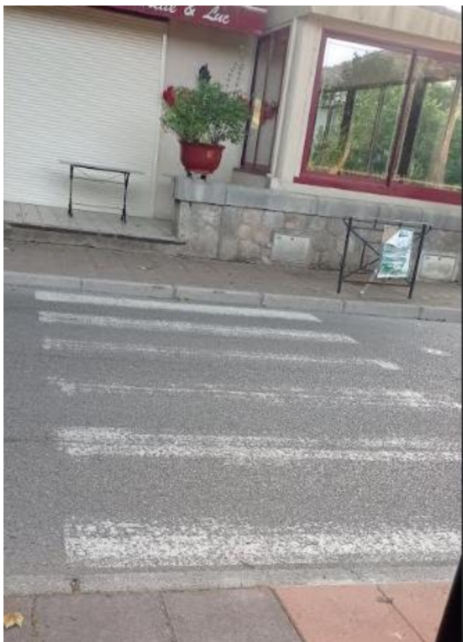
Passage piétons avenue René Boudon (au niveau du restaurant de la gare). Faire des bateaux de chaque côté
